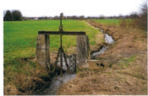
Wässerungswehr in der Elzau bei Emmendingen / Baden-Württemberg
